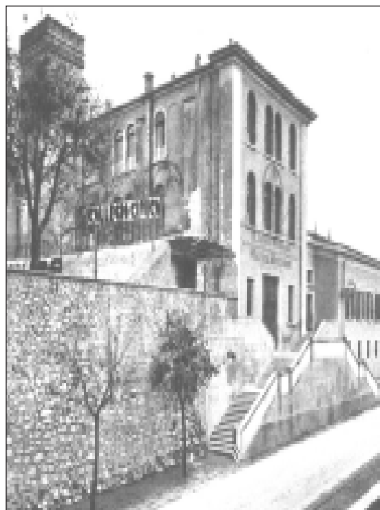
Vecchia Via Brunati con l'osservatorio e le scuole di Avviamento
